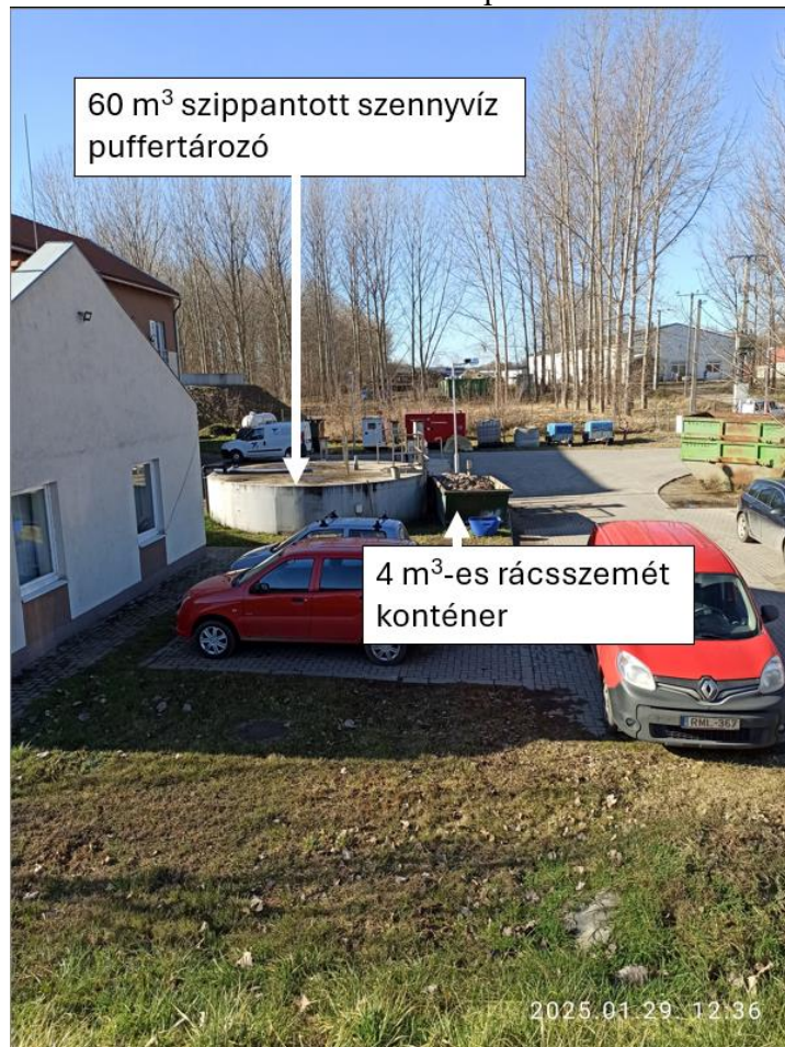
69. ábra: Szippantott szennyvíz tározó
