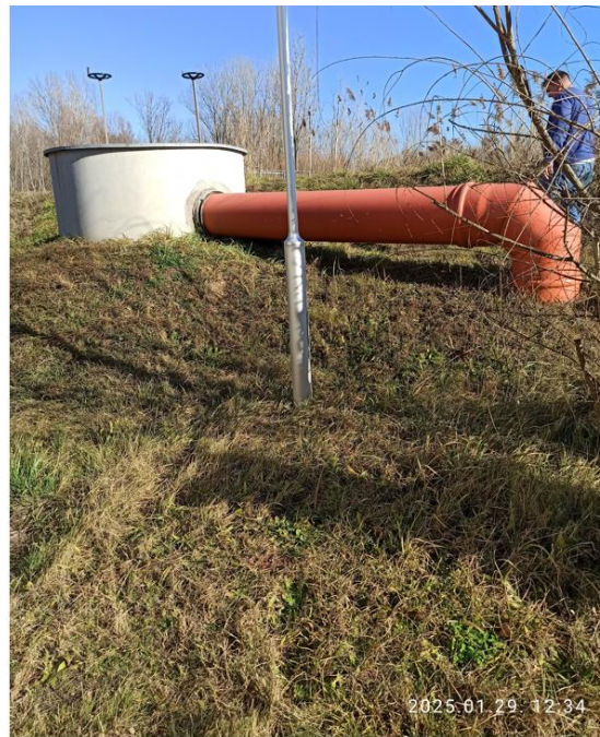
71. ábra: Vízkormányzó akna (Forrás: Saját fotó helyszíni bejárás, 2025.01.29.)
